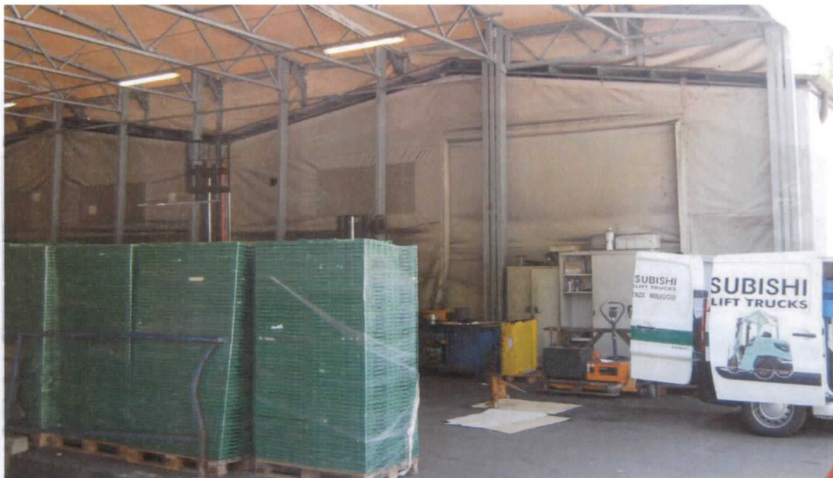
Vista dall'interno della aggregazione di tettoie in metallo (n.8) che compongono l'edificio 5
