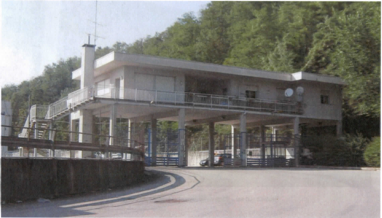
Facciata sud-est – Vista complessiva dall'ingresso
