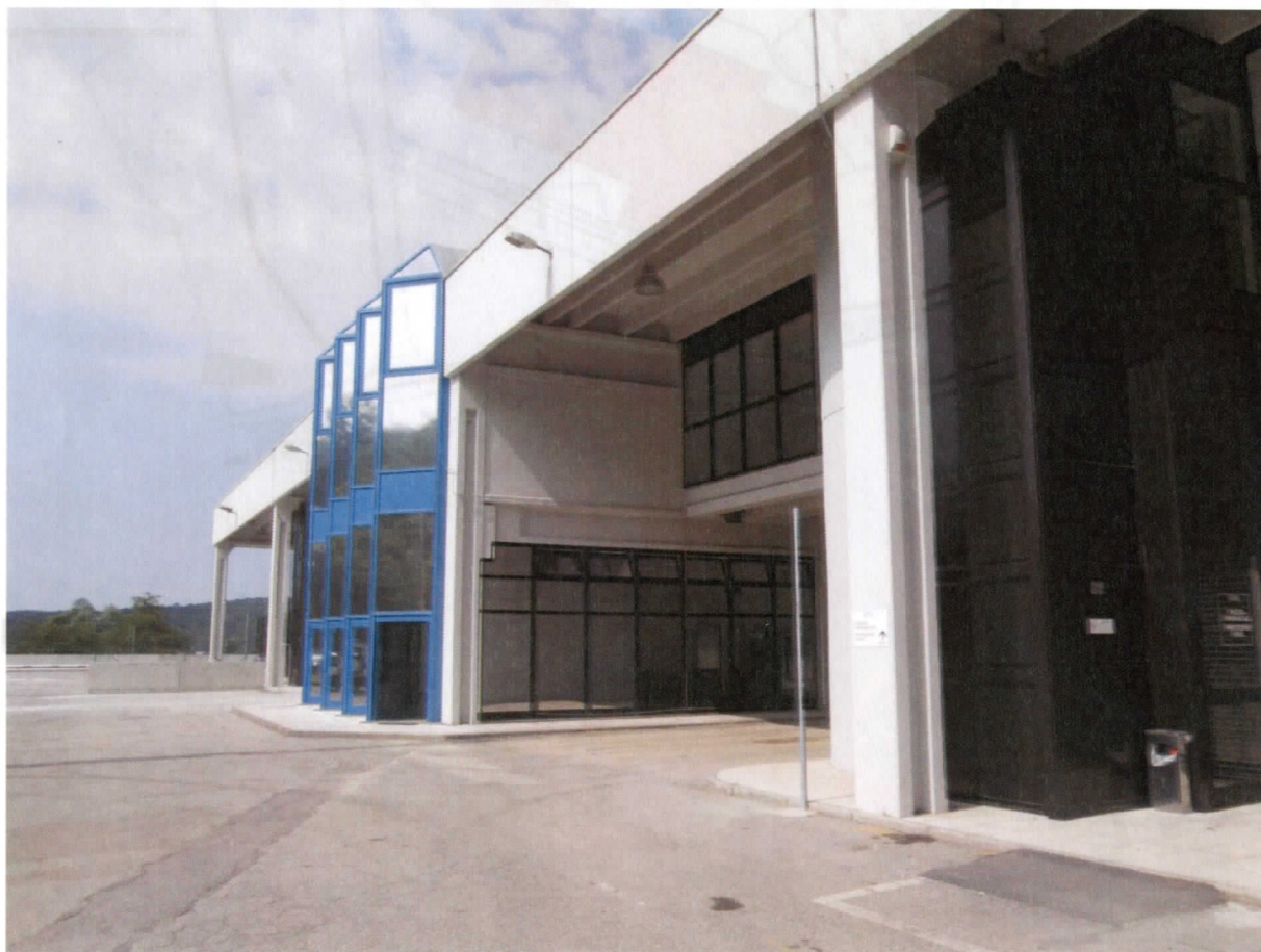
Facciata sud-est – Vista complessiva
