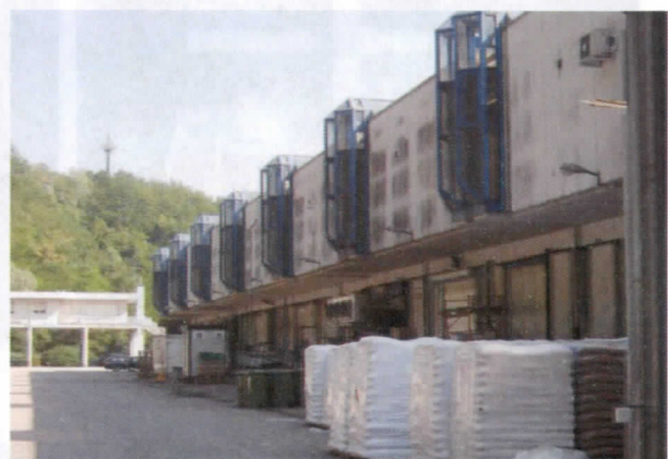
Facciata nord-est – vista d'insieme
