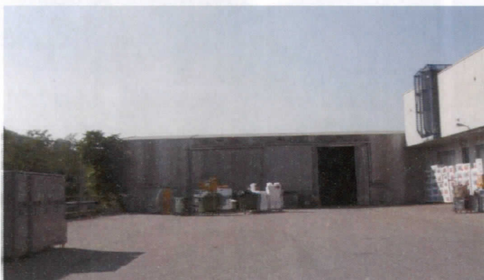
Facciata sud-est – accessi laterali
