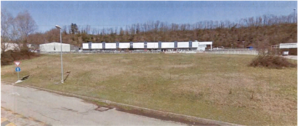
Vista del complesso immobiliare dalla Via Fontanelle – Fonte Google Street
