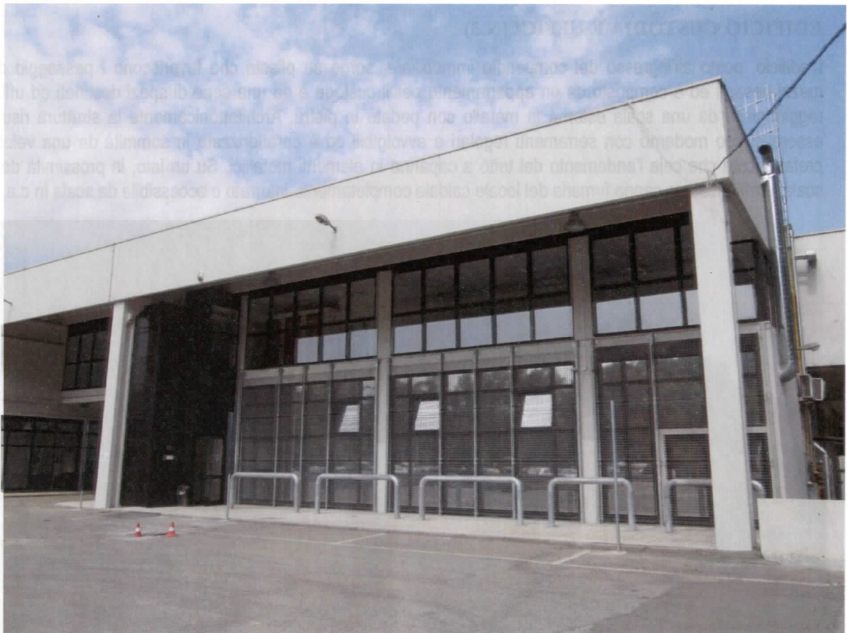
Facciata sud-est – Porzione ricadente nel territorio del Comune di Malnate
